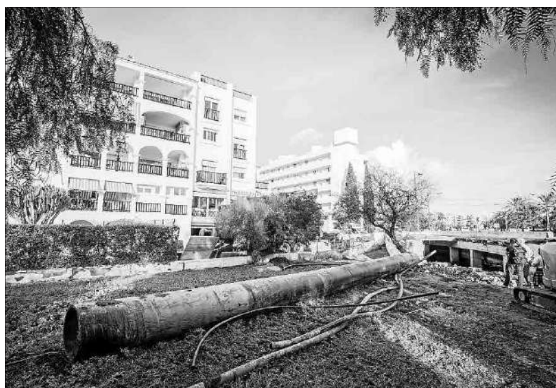
La tubería, totalmente nueva y fabricada en polietileno, tiene un diámetro de 710 mm y para seis atmósferas de presión. Foto: TONI P.
